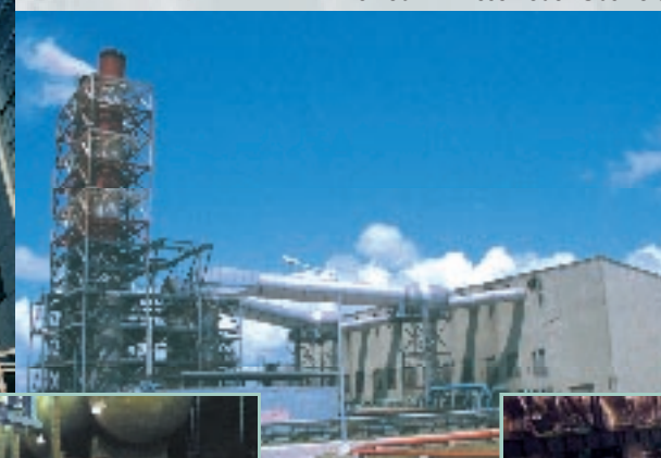
Betrieb mit Diesel- oder Gasmotor
