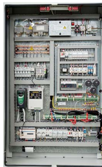
Fig. 2 : armoire ouverte avec grille de câblage "Facteur de puissance" montée
