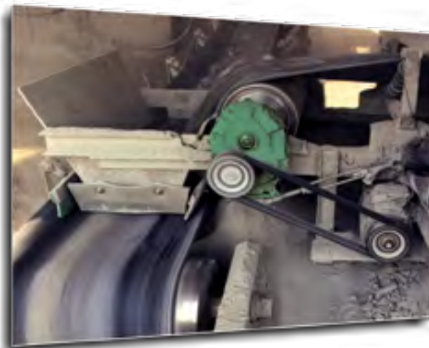
.....> accionamiento de cinta transportadora
