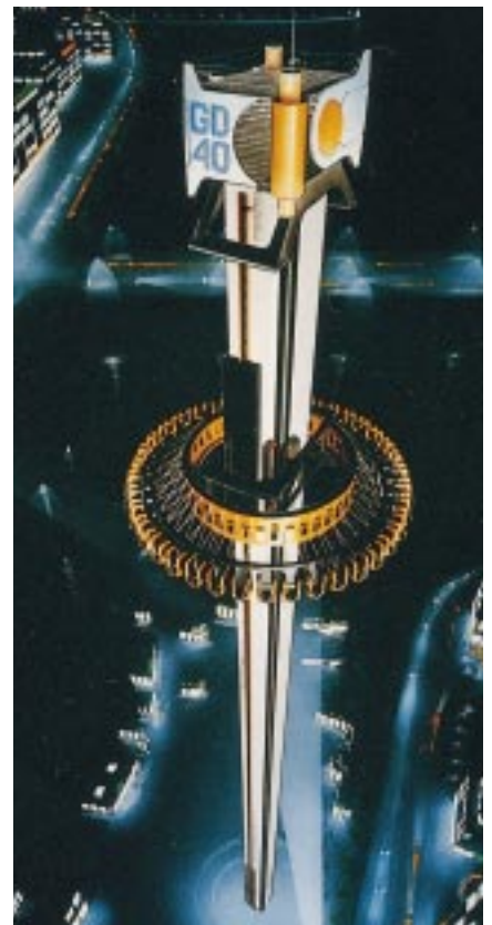
GYRO DROP. Zur Hochbeförderung der Passagiere: zwei Gleichstrommotoren LSK 2804 CL - 450 kW.
