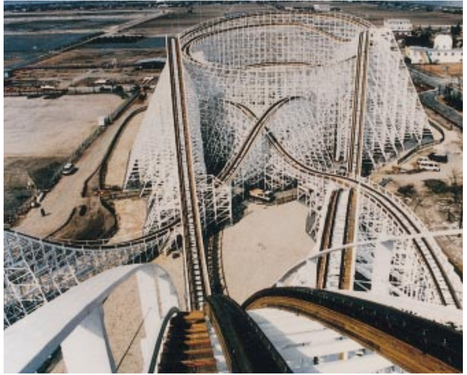
WOODEN COASTER. Ausgerüstet mit Getriebemotoren Orthobloc. Bremsmotoren und ein Gleichstrommotor LSK 1804 VL - 160kW.
