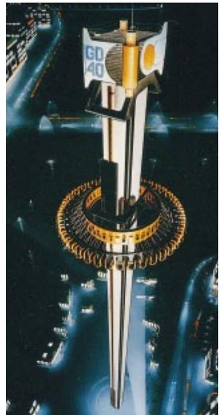
GYRO DROP. Equipé de deux moteurs DC LSK 2804 CL - 450 kW
