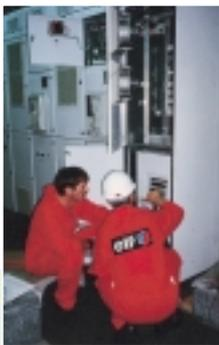
Leroy-Somer gehört zu den großen Lieferanten von ELF für die Offshore-Plattformen. Frequenzumrichter der Reihe UMV zusammen mit spezifischen Transformatoren übernehmen die Steuerung und den Schutz der Tiefbohrlochpumpen, die eingesetzt werden, um die Förderung des Erdöls zu aktivieren. Die vor Ort realisierte Ingenieurarbeit umfaßt den Schutz der Leitung durch geeignete Filter. Leroy-Somer gewährleistet auch die vorbeugende Wartung und die Instandsetzung an diesen Standorten.
