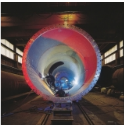
Fabricatie van de masten
