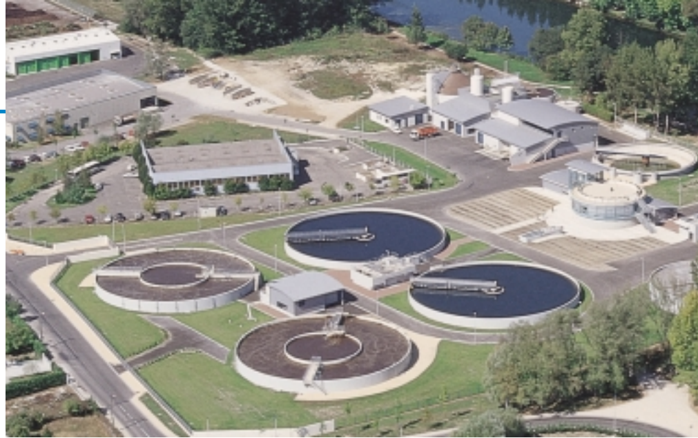
Die neue Kläranlage von Angoulême umfaßt 134 Antriebssysteme von Leroy-Somer. Kapazität: 97000 Einwohneräquivalente. Durchsatz: 9000 bis 27000 m 3 pro Tag.
