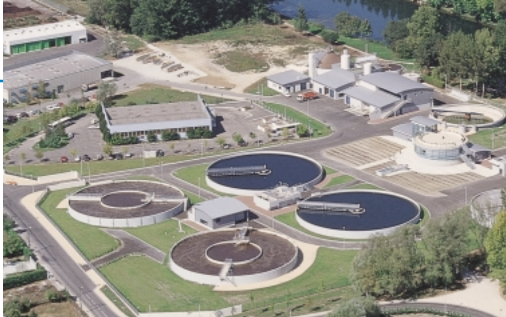
Det nye rensningsanlæg i Angoulême der indeholder 134 rensningssystemer fra LEROY-SOMER. Kapacitet: 97.000 Ækvivalent/Indbyggere. Udledning: 9.000 – 27.000 m 3 /dag.
