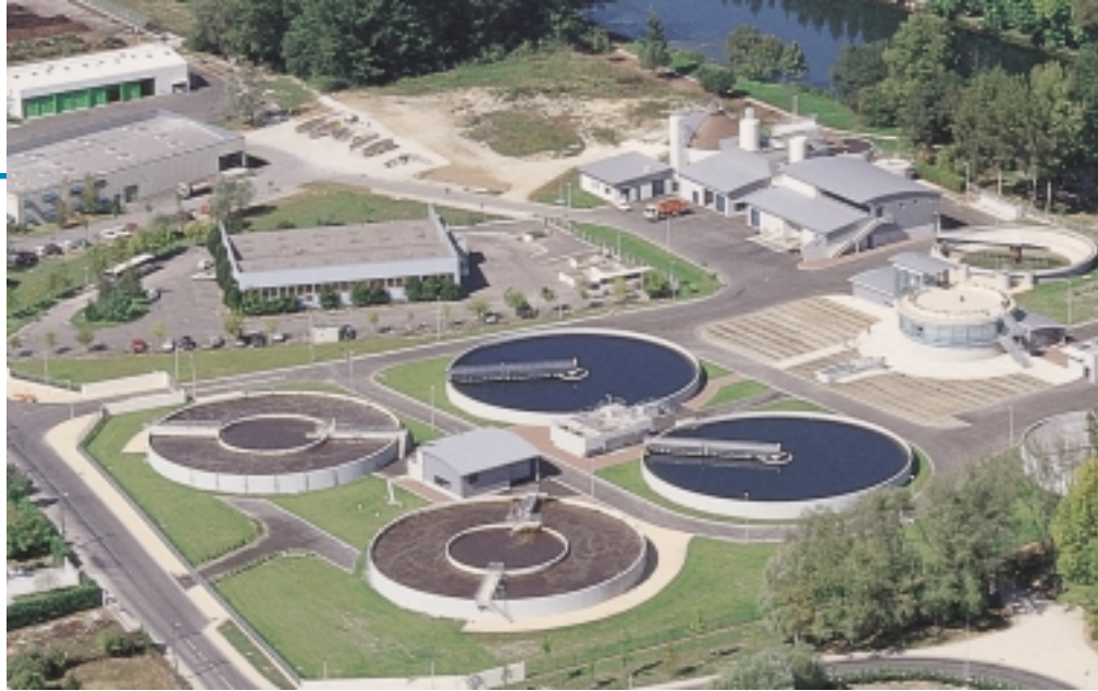
Het nieuwe waterzuiveringsstation van Angoulême met 134 aandrijfsystemen van Leroy-Somer. Capaciteit: 97 000 inwoners. Capaciteit: 9 000 tot 27 000 m 3 /dag.
