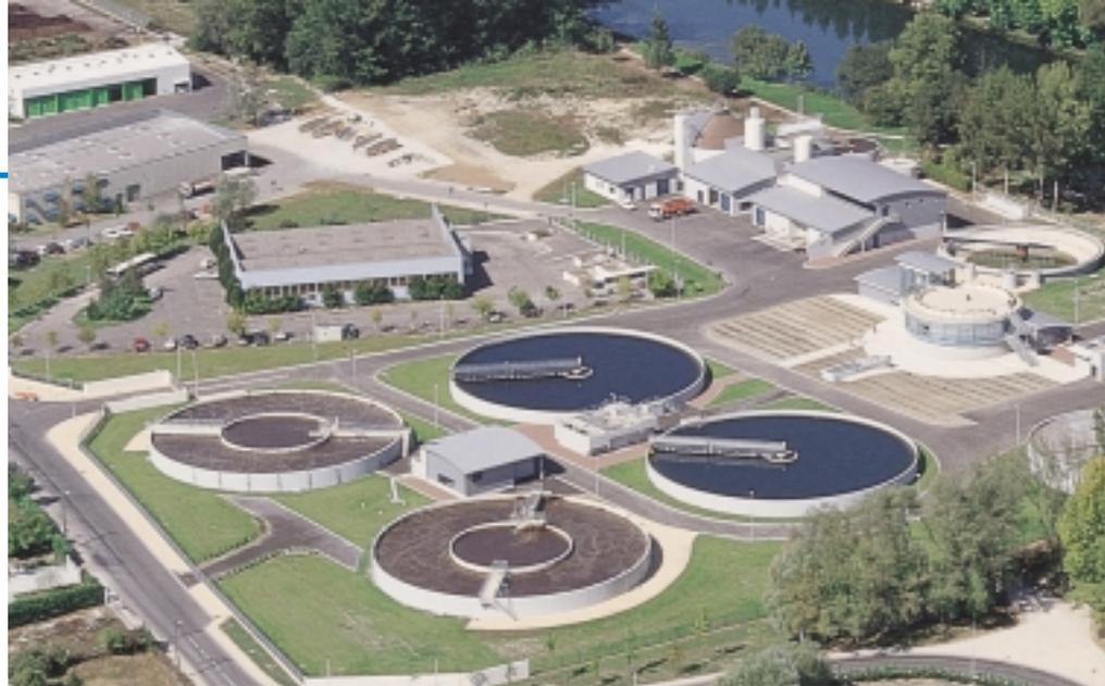
Die neue Kläranlage von Angoulême umfaßt 134 Antriebssysteme von Leroy-Somer. Kapazität: 97000 Einwohneräquivalente. Durchsatz: 9000 bis 27000 m³ pro Tag.
