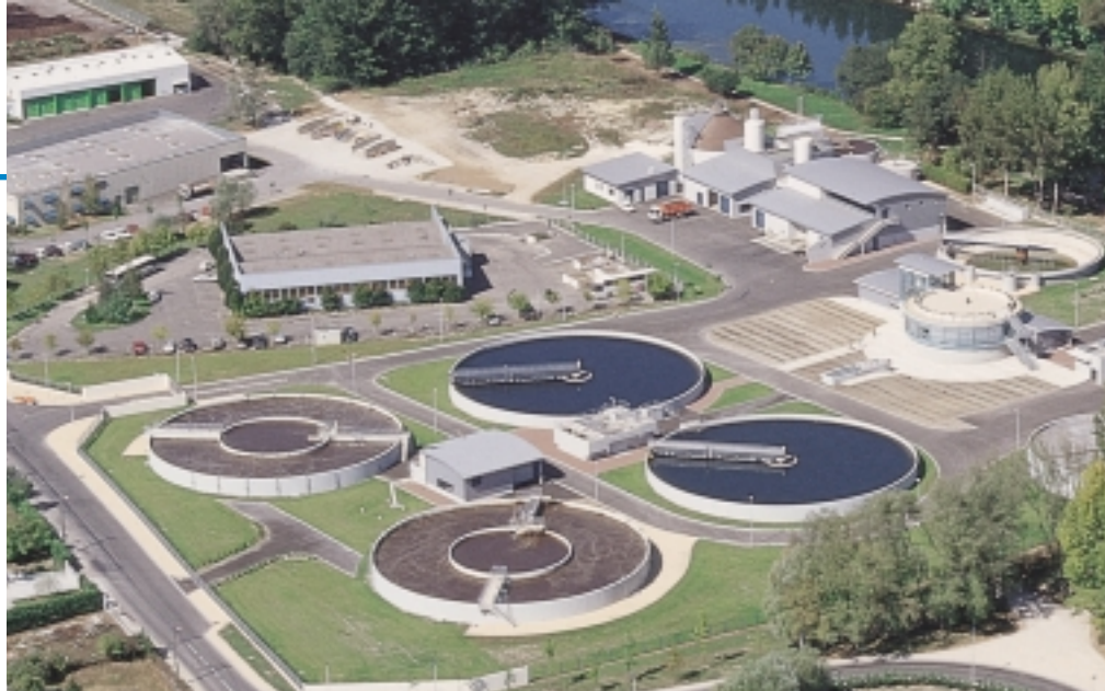
La nouvelle station d'épuration d'Angoulême comprenant 134 systèmes d'entraînement LEROY-SOMER. Capacité: 97 000 Equivalent/Habitants. Débit: 9 000 à 27 000 m 3 /jour.
