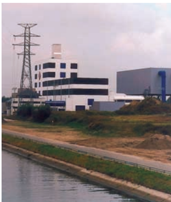
Kombineret kraftværk (360 MW) til Electrabel (Gent - Belgien)
