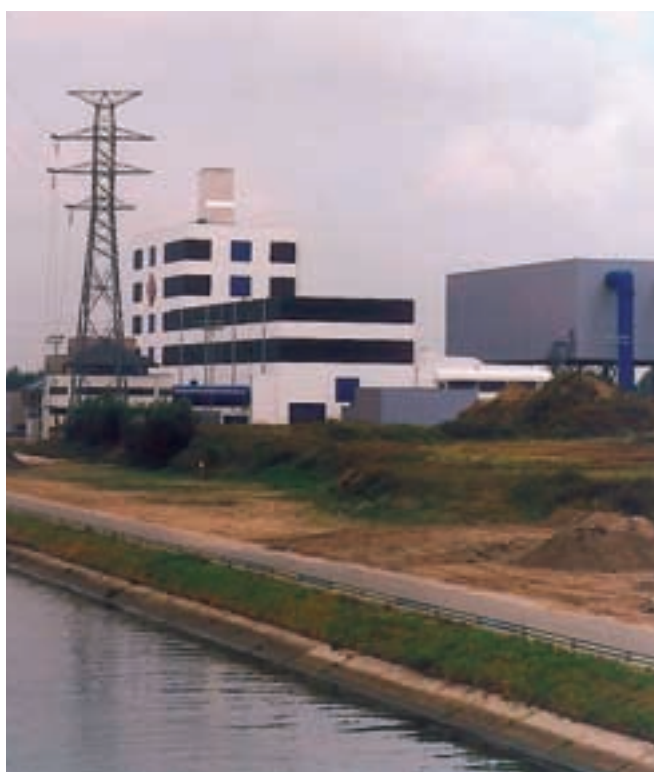
Central de ciclo combinado (360MW) para Electrabel (Gante - Bélgica)
