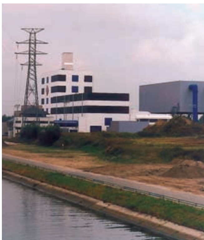
Centrale met gecombineerde cyclus (360 MW) voor Electrabel (Gent-België)
