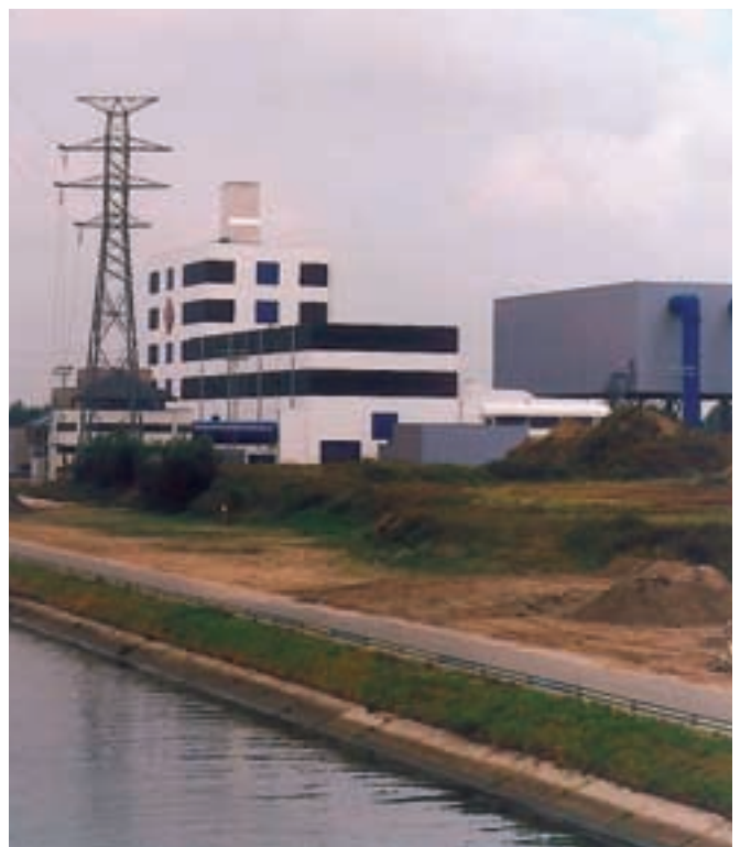
Kombiniertes Gas- und Dampfturbinenkraftwerk (360 MW) für Electrabel (Gent - Belgien)
