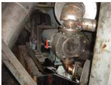
Les pièces internes de cette pompe avaient, en surface, une dureté de 1400 Vickers, ce qui permettait de réduire considérablement l'usure. Les pompes à pistons transvasaient, en service ininterrompu, les liquides usés de la citerne, directement vers la chambre de combustion. Sur des installations de ce type, on devait compter sur un entraînement fiable et de qualité.
