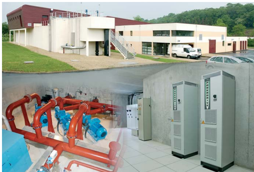
Vue d'ensemble du site, des pompes et variateurs
