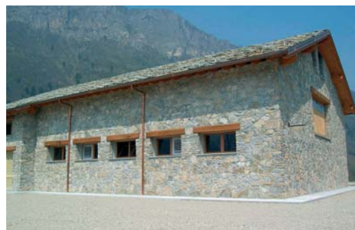
Vista della Centrale FORANI
