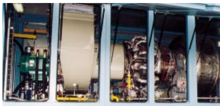
Francia - Industria chimica. Gruppo turbogeneratore (cogenerazione) che eroga una potenza elettrica di 6,8 MW, di cui 4 MW sono utilizzati per il processo produttivo e i restanti vengono rinviiati in rete. Produttore: Tuma Turbomach SA (Svizzera)
