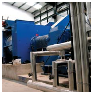
Hele processen med at udnytte energien fra trærester i biomassefabrikken i Villacañas er drevet af motorer, gearmotorer og vekselstrømsgeneratorer fra Leroy-Somer, der er godkendt til atmosfærer med eksplosionsfarligt støv (ATEX støv).
