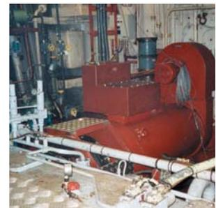
*O Esperanza está equipado com um alternador LSAM52.2 de 1300 kVA que alimenta os motores de propulsão electrónicos. A rede de bordo está equipada com um alternador de linha de veio LSAM50.1M6 de 450 kVA. Dois variadores de velocidade do tipo UMV3301-600T asseguram a regulação dos motores de propulsão PLS 450LB-400kW 600rpm.*
