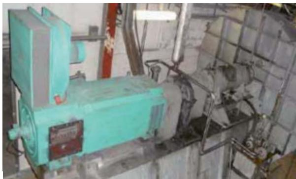
Installation avant : moteur courant continu 455kw 1300tr avec multiplicateur.
