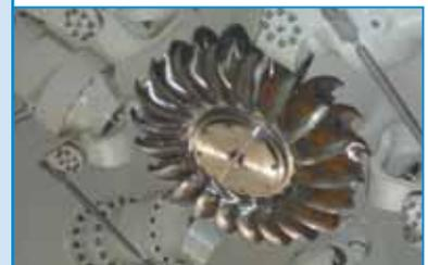
*Diferentes vistas das centrais eléctricas de Ytre Alsåker kraftverk e de Årvik (Noruega) que incluem, ambas, um alternador LSA 58 de eixo vertical, 5490 kVA, 6600 V, 600 rpm, com uma roda turbina Pelton – 6 jactos – montada em falso sobre o veio do alternador.*
