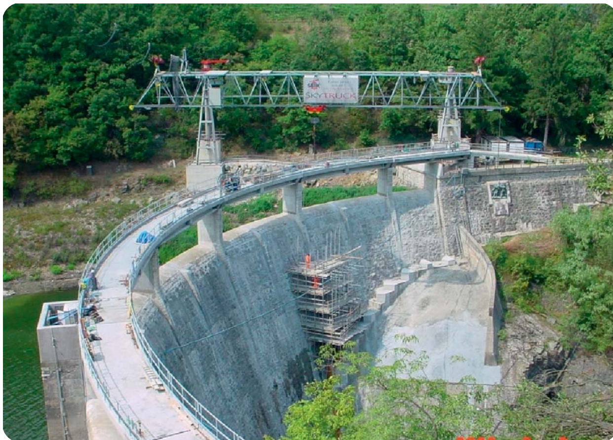
I lavori alla diga di Spigno Monferrato
