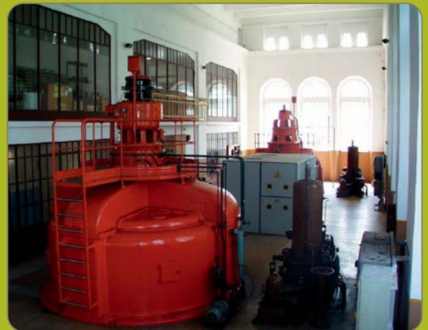
L'interno della centrale prima degli interventi
