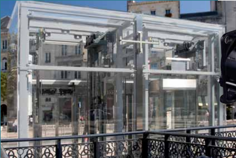
Maschinenraumlose Aufzüge (Bordeaux). Gearless-Motor XAP2M der Baureihe XA
