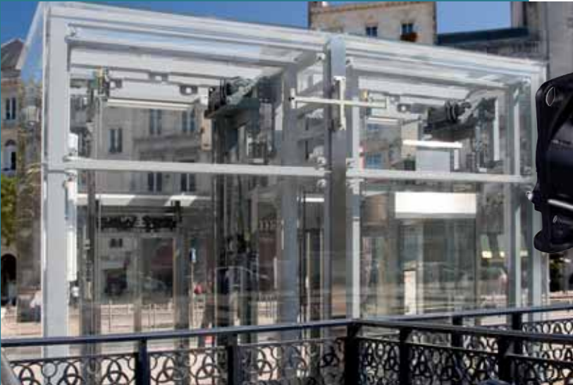
Elevator uden maskinrum (Bordeaux). XA-serien, XAP2M-motor uden gear.
