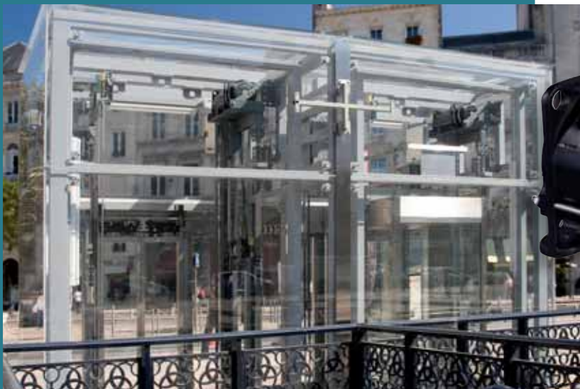
Ascenseur sans salle des machines (Bordeaux). Gamme XA moteur gearless XAP2M
