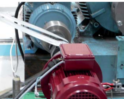
Figuur 1 – Installatie van meetapparatuur (PM-motor van 5,2 kW, koppelmeter en generator)
