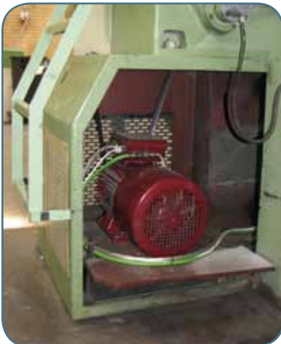
...blev udskiftet med en energibesparende LSRPM motor.
