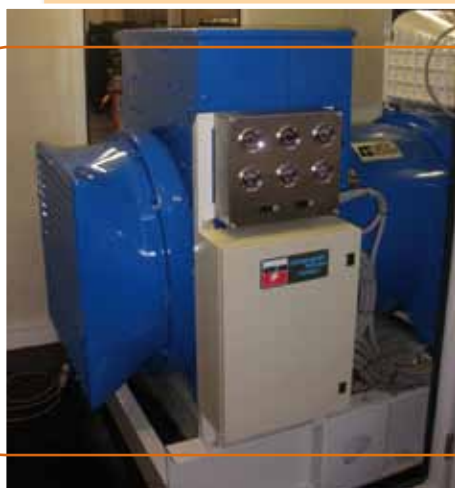
Alternateur de la gamme basse tension élargie LSA 53.1 M80 / 4P - 2300 kVA - 400V
