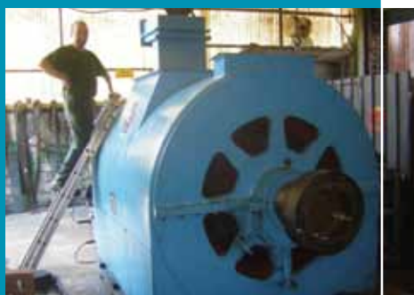
Remise en état d'un moteur de centrale hydraulique (3 kV - 550/590 A - 750 T/m - 2850 KVA)
