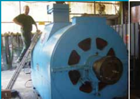
Reparatie van een motor in een hydraulische centrale (3 kV – 550/590 A – 750 min -1 – 2850 kVA)
