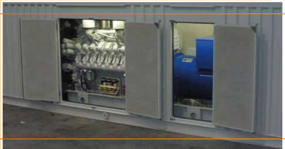
Dieseldrevet nødgenerator installeret i et rensningsanlæg i M'Boundi i Congo.
