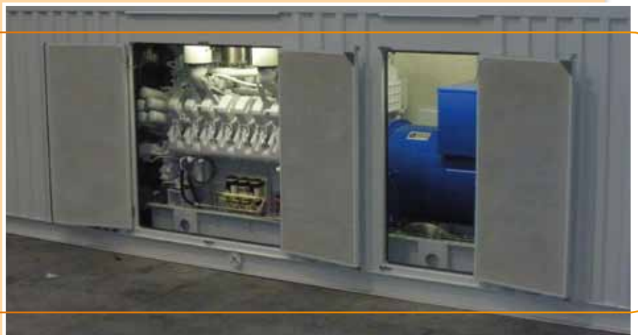
Groupe électrogène Diesel de secours installé dans une usine de traitement située à M'Boundi en République du Congo.
