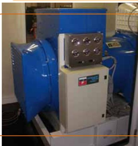
*Alternatore della gamma bassa tensione ampliata
