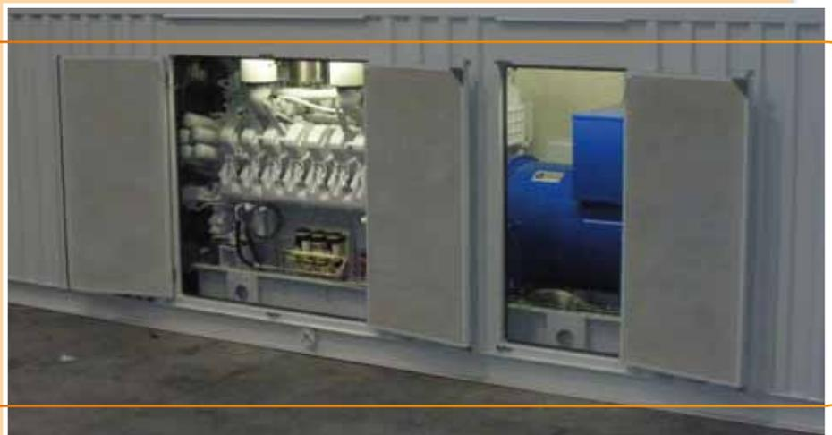
*Grupo electrógeno Diesel de emergência instalado numa fábrica de tratamento em M'Boundi na República do Congo.*
