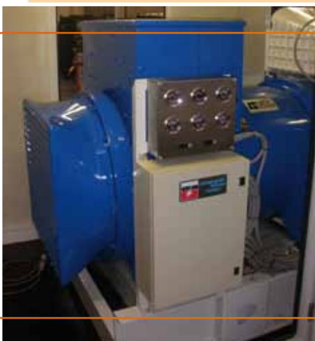
Alternador de la gama de baja tensión ampliada LSA 53.1 M80/4P - 2300 kVA - 400 V
