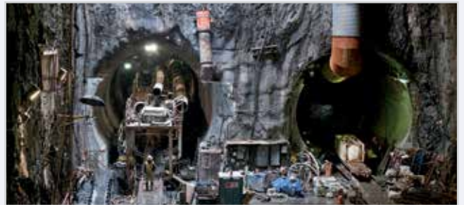
Vue de la construction sous le niveau inférieur actuel de Grand Central Terminal, à New York. (Photo de la Metropolitan Transportation Authority de l'État de New York / Patrick Cashin).
