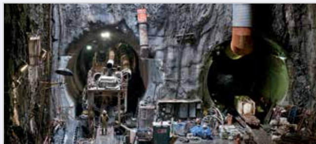
Foto van de constructie onder het bestaande laagste niveau van Grand Central Terminal, New York. (Foto van de Metropolitan Transportation Authority van de Staat New York/ Patrick Cashin).
