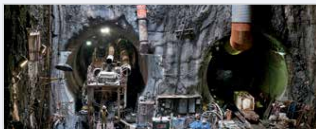
Widok budowy poniżej istniejącego poziomu dolnego terminalu Grand Central w centrum Nowego Jorku. (Fotografia wykonana przez Metropolitan Transportation Authority stanu New York / Patrick Cashin).
