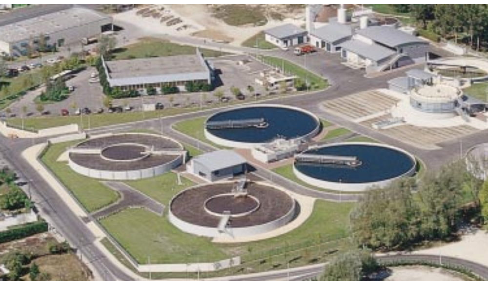
Estação de tratamento de águas residuais de Angoulême que inclui 134 sistemas de accionamento Leroy-Somer. Capacidade: 97 000 Equivalente/Habitantes. Débito: 9 000 a 27 000 m 3 /dia.
