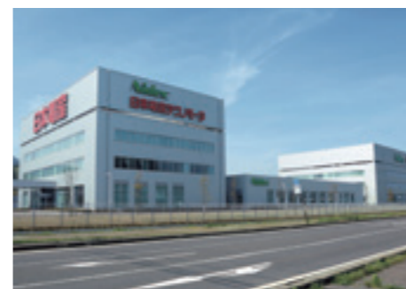
Fukui Technical Center (Headquarters and R&D) 本社・福井技術開発センター
