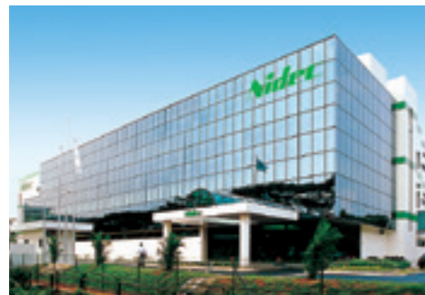
Headquarters (Singapore) 本社 (シンガポール)
