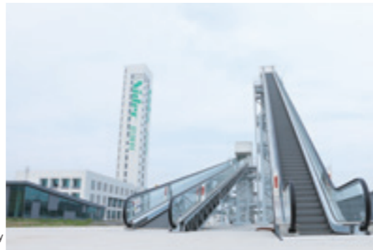
Nidec Test Facility Nidecテスト施設
