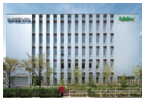
Headquarters and Tokyo Technical Center 本社・東京技術開発センター
