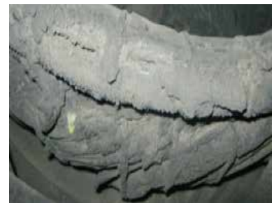
应用于炎热的工业环境下发电机上所出现的典型沉积物（棕榈油炼油厂）
